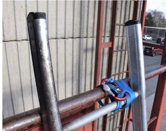
Avec une sangle et un connecteur du LSPCC.
